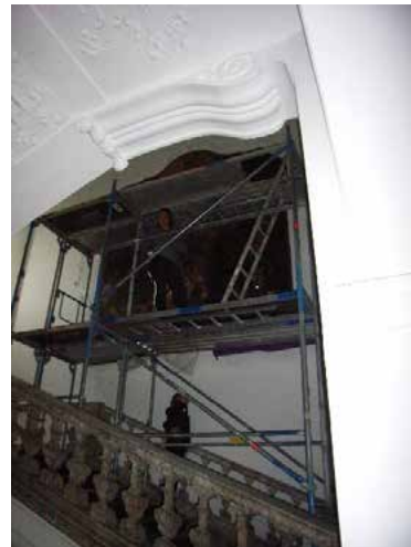
Einbau im Treppenhaus
