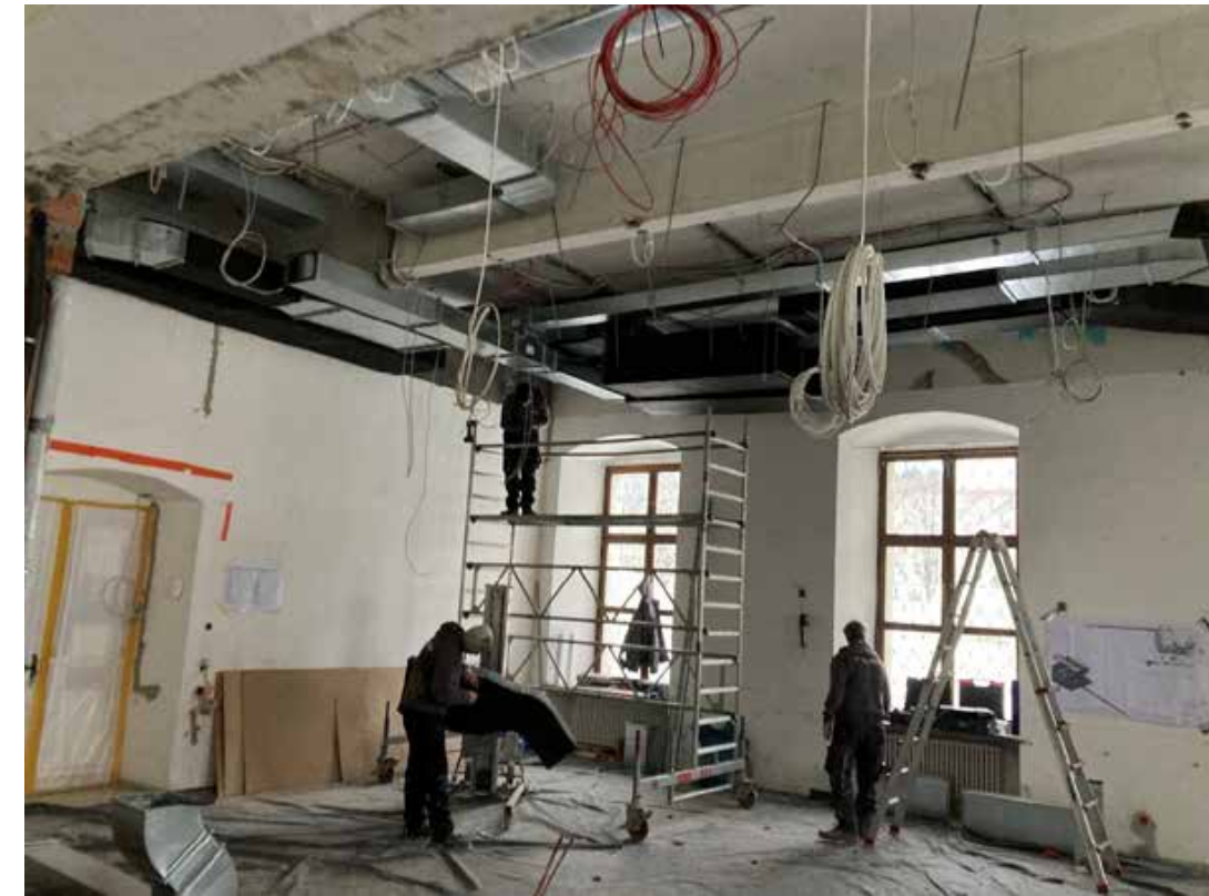
Klostercafe – Verlegung Lüftungsrohre
