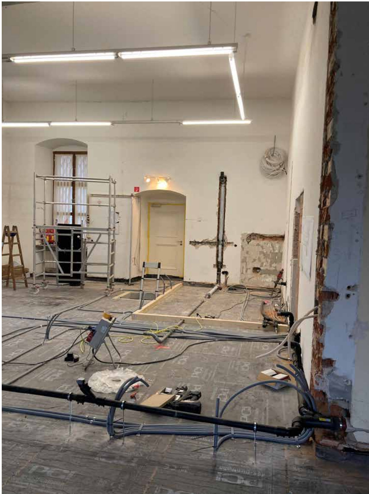
Klostercafe - neue Abdichtungen und Elektroinstallation
