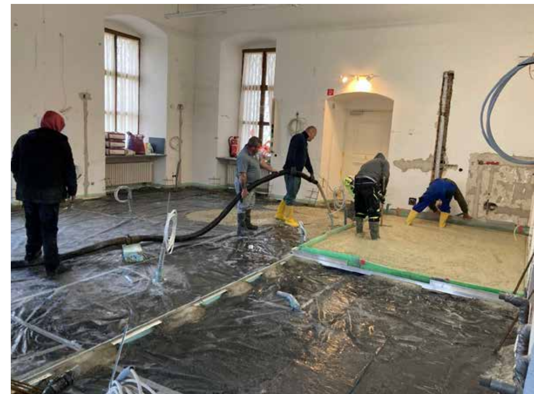
Klostercafe – Verlegung Terrazzoboden
