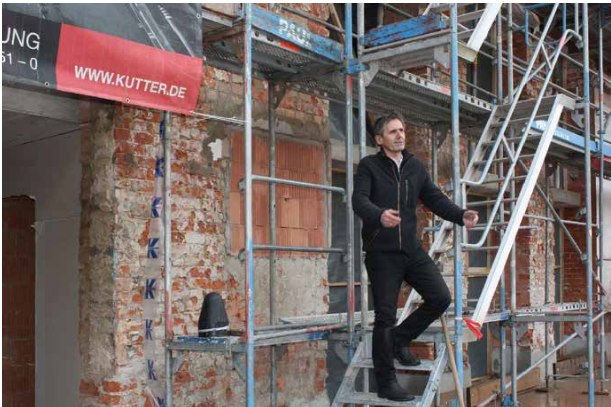
Architekt und Bauleiter Franz Arnold beim Hebauf
