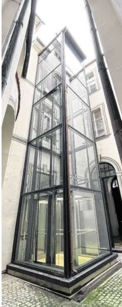
Ein gläserner Aufzug wurde an eine Außenwand des Klosters gebaut.
