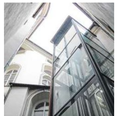
In einem Innenhof wurde ein gläserner Aufzug eingebaut.
