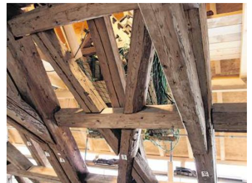
Im Dachstuhl des Kaisersaalbaus werden gerade morsche Balkenteile ausgetauscht. Eine Gaube wurde derweil in einem Netz nach oben gezogen (hinten).
