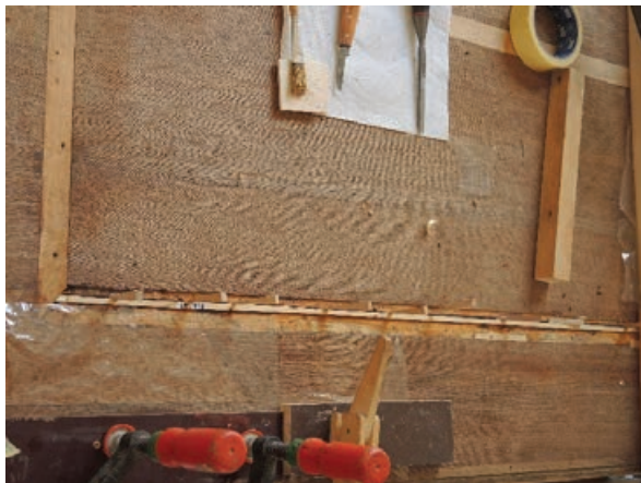
Ausspannen der Risse
